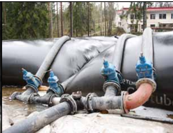
Откачка в геотекстильные трубы
