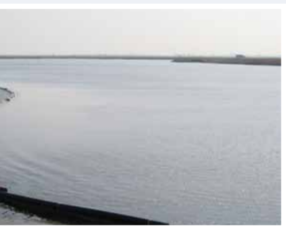
Работы землесоса в Штеерплогциль
