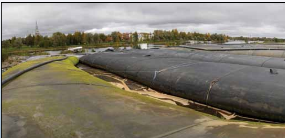
Десятки геотекстильных труб были заполнены загрязненными отложениями
